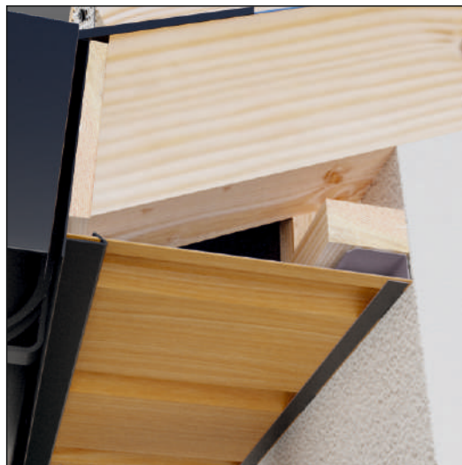
Підшиву монтуємо до планок.
