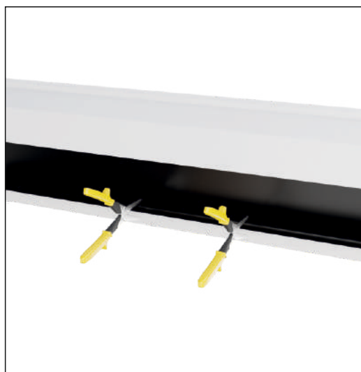
Вирізаємо накладку, використовуючи для цього ліві/праві ножиці по металу.
