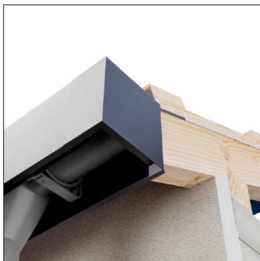
Змонтована водостічна система без підшиви.
