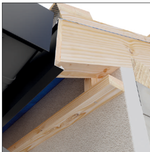
Облаштовуємо підконструкцію для монтажу підшиви.
