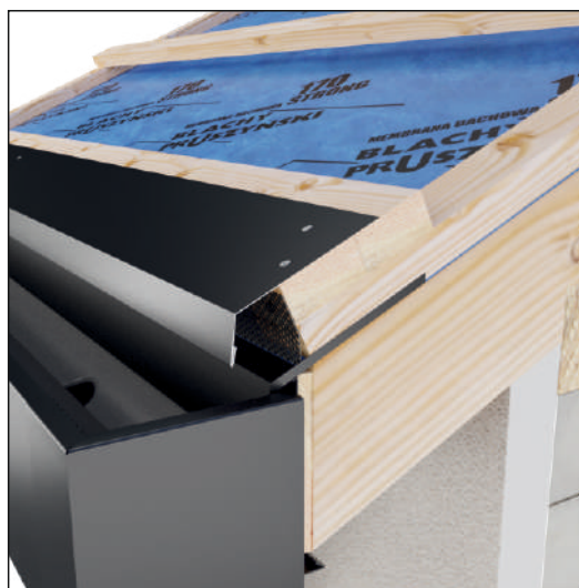
Встановлення карнизної планки.
