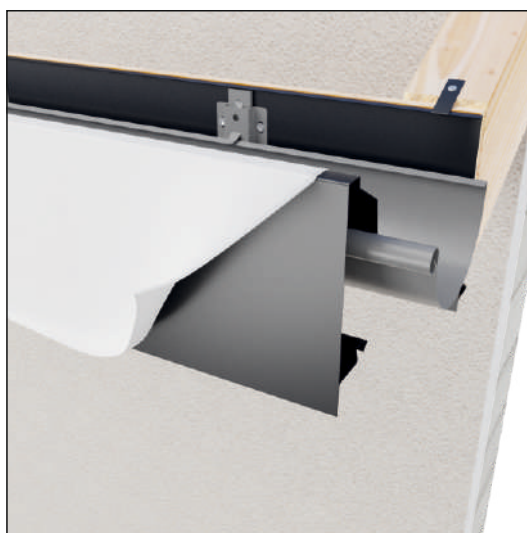
Після того, як накладку змонтовано до ринви, знімаємо захисну плівку.
