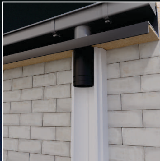
Монтаж частини обшивки, що розташована біля стіни.
