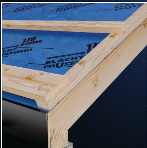
Монтування підконструкції згідно інструкції монтажу покрівлі. Монтаж подвійної рейки біля карнизу.
