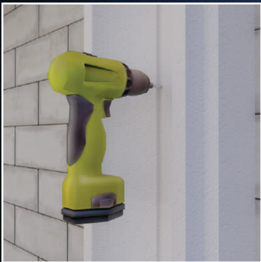
Свердлимо отвори для кріпильних шпильок, до яких кріпитимуться обійми водостічної труби.
