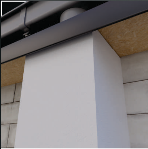
Накладки, змонтовані на трубі.
