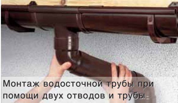
Монтаж водосточных труб
